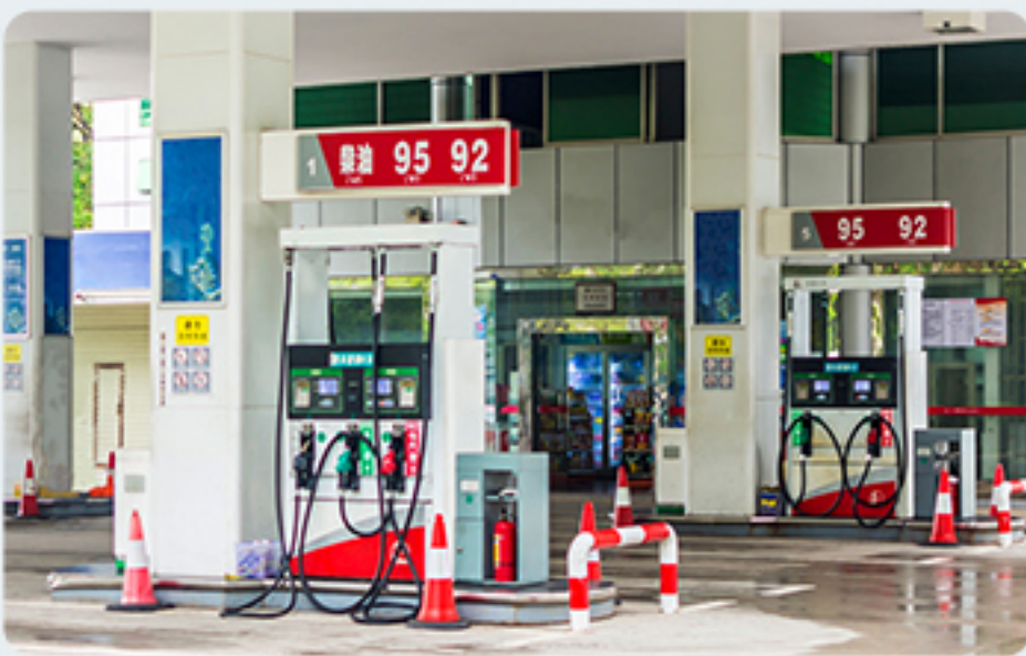
智慧加油站、充电站
